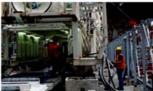
Lavori Operai nel cantiere della metropolitana linea C
